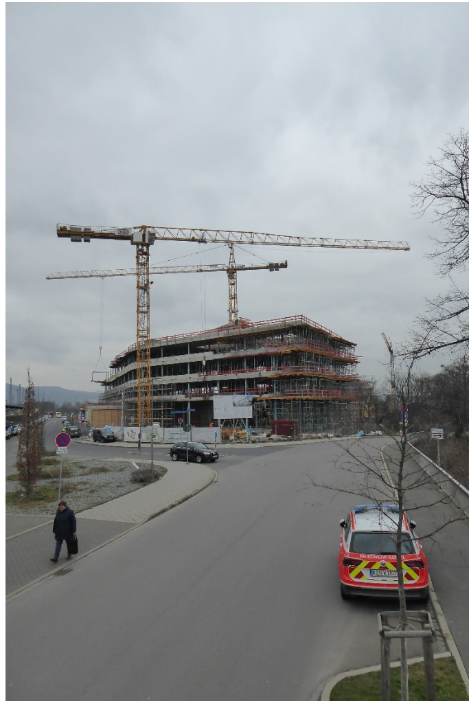
Baustelle Fraunhofer Institut, Joseph-Beuys-Straße
