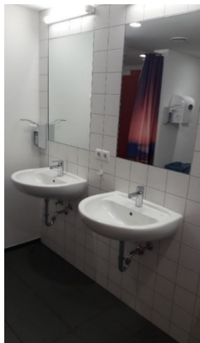
Ein Teil des neuen Sanitärbereiches auf der Feuer- und Rettungswache 2
