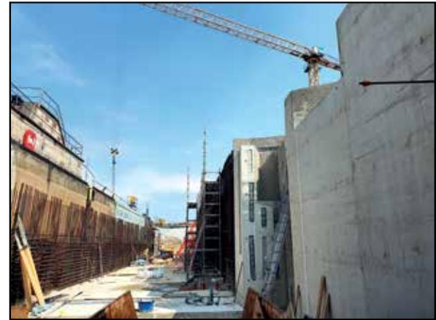
*Betonierte landseitige Wand des Oberhauptes. Hier wird das neue Schleusentor eingebaut.*
