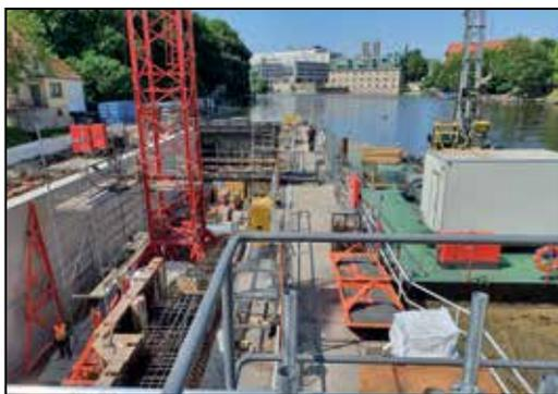
*Hier sehen wir den künftigen Vorhafenbereich im Oberwasser. Die Uferwand ist bereits betoniert und ausgeschalt.*
