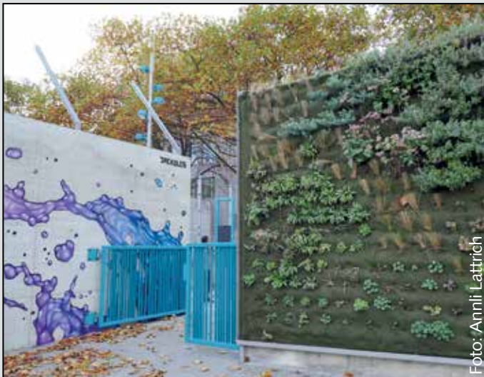
Die Betonwand, gestaltet vom Profisprayer „Jackules“, mit dem vertikalen Begrünungssystem.
